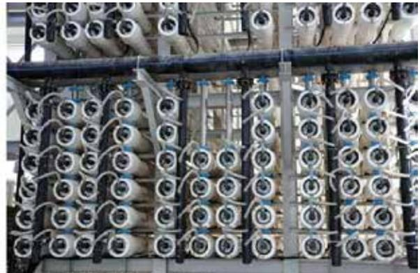
مع وجود خمس توربينات غازية واثنتين من التوربينات البخارية، تبلغ سعة الطاقة المتعاقد عليها ٤٤٥ ميغاوات. ويعتمد إنتاج المياه في المحطة على عملية التناضح العكسي وسعة إنتاج المياه المتعاقد عليها هي ١٥ مليون جالون إمبريالي يوميًا. ودخلت المحطة مرحلة التشغيل التجاري الكامل في ٢٥ مايو ٢٠١٢.
